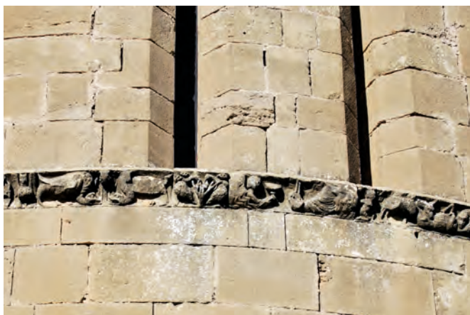
Friso exterior del ábside de la iglesia de Santiago de Agüero. En el centro, la mano de Dios bendiciendo el cáliz que le presenta un ángel.
