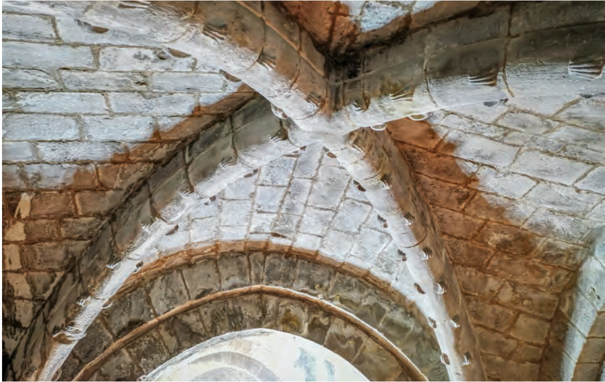
Véneras en los nervios de las bóvedas cercanas a la puerta norte de San Esteban de Sos. Autor: Fran Calvo.
