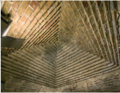
Arriba, bóveda de aproximación de hiladas en la parte inferior de la torre. A la derecha, custodia en el interior del templo.
