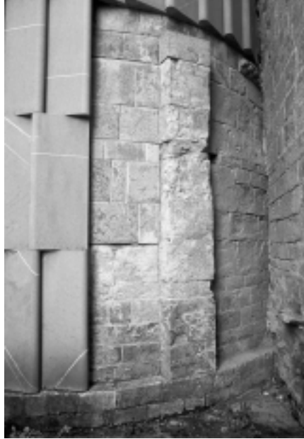
Lám. 11. Catedral de San Pedro de Jaca (Huesca). Detalle del exterior del ábside septentrional en el que se ve una lesena medial entre dos planos rehundidos concebidos para ser coronados por arquillos ciegos. Las siete primeras hiladas de sillarejo son lombardistas , mientras que las siguientes de sillería son ya del primer arte jaqués.
